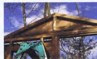
5 妻壁を取付け
