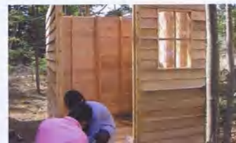
4 壁パネルを立てる
