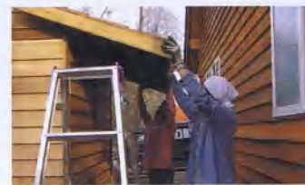
6 屋根パネルを載せる
